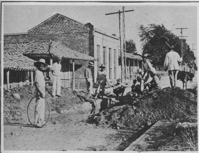
Hueco abierto por el temblor en una de las calles vecinas al hospital de Santiago. (Foto LGW)
